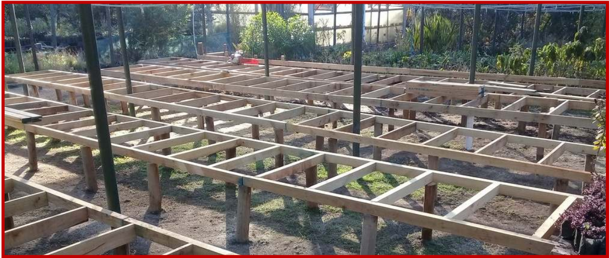
Nuevas platabandas en construcción
